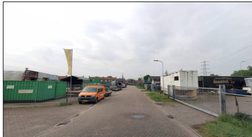
Breede Goorstraat in 2023: overbodige verharding
